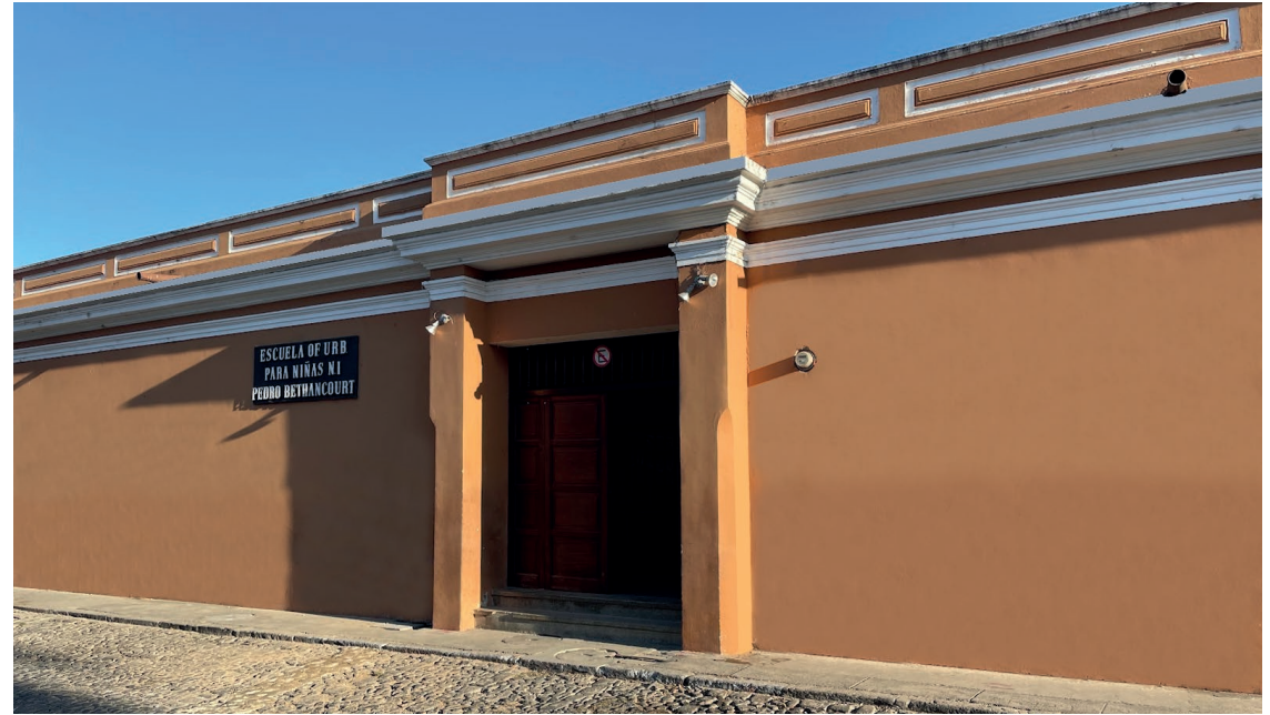
20- Casa Esquinera Surponiente. En la actualidad, Escuela para Niñas “Pedro de Bethancourt”.
