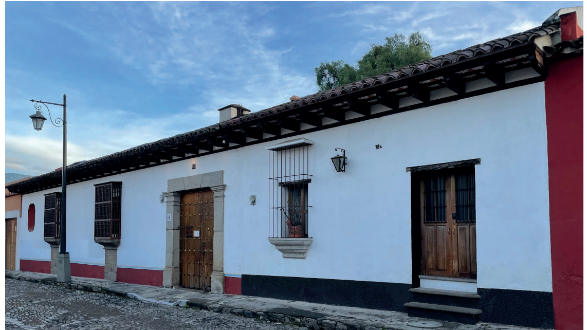
16- Casa Central del Lateral Sur.
