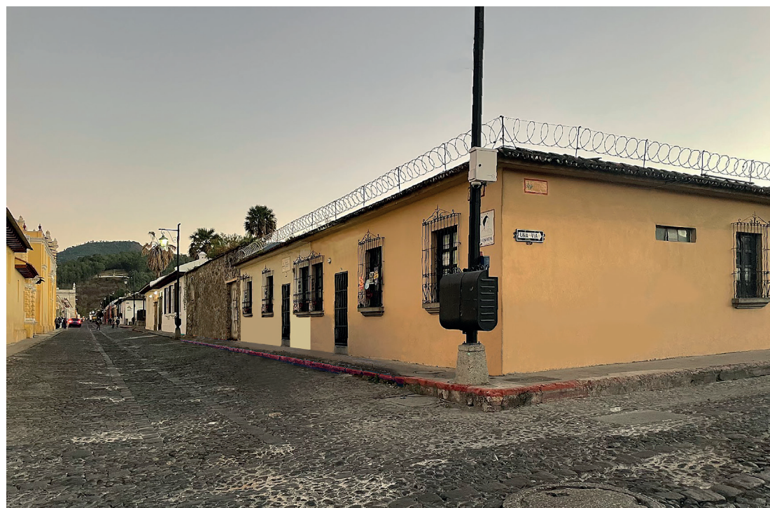
17- Casa Esquinera Surponiente
