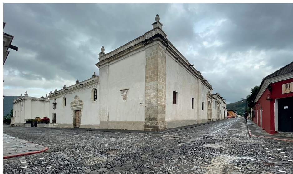
14- Casa del Sacristán Mayor en la Esquina Suroriente.
