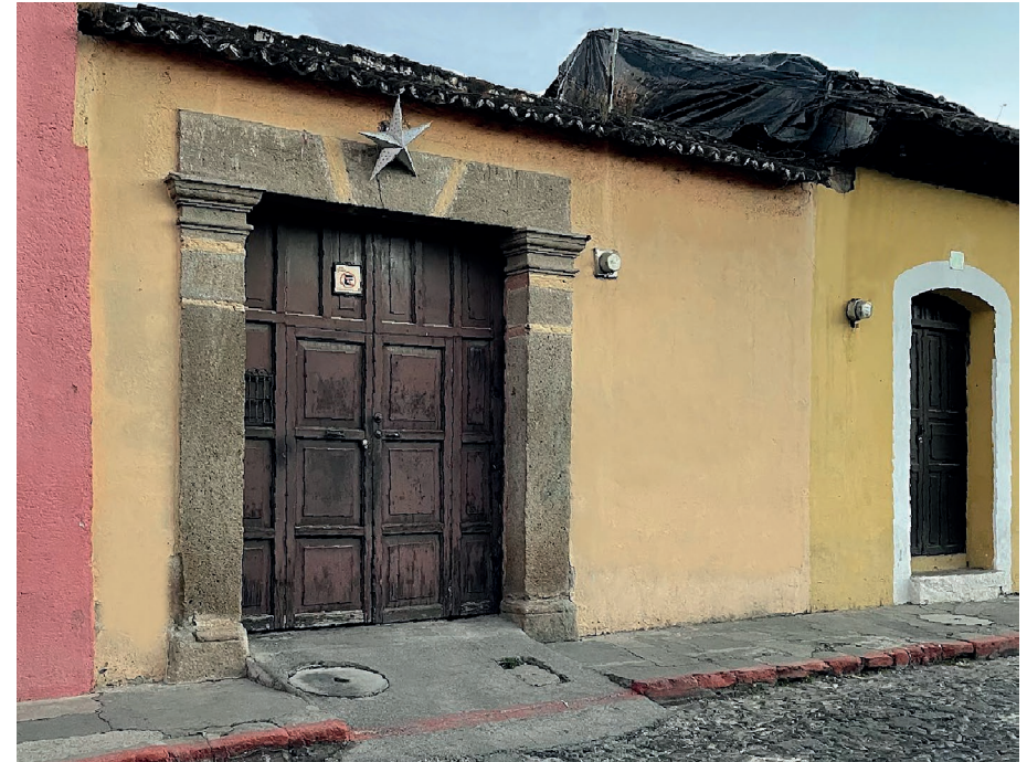
15- Casa Central Poniente del Lateral Sur.
