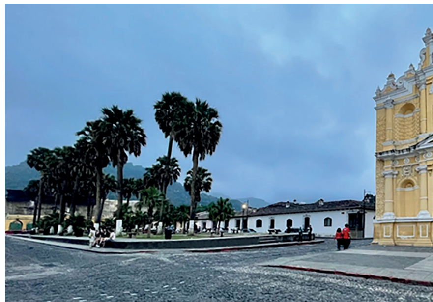
3- Casa Esquinera Norponiente, ubicada a la izquierda de Iglesia de San Pedro.
