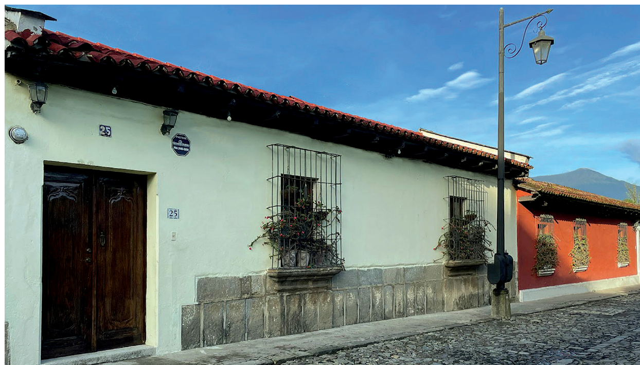
8- Casa Central Oriente del Lateral Norte.
