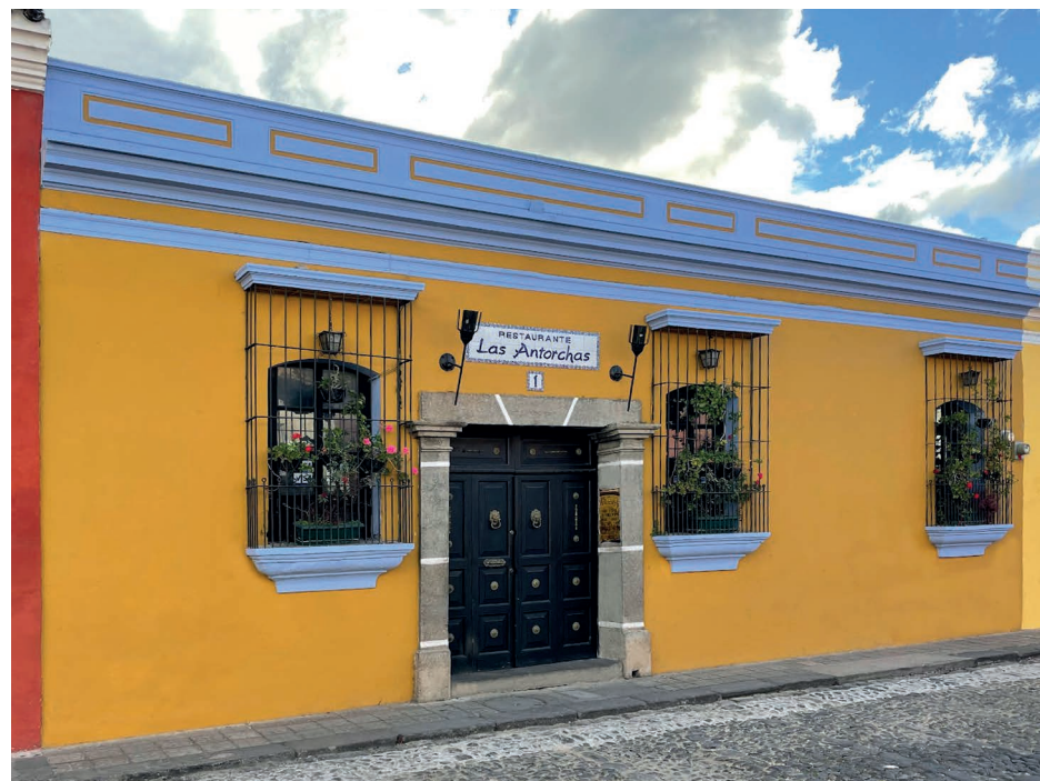
20- Casa Central del Lateral Poniente.
