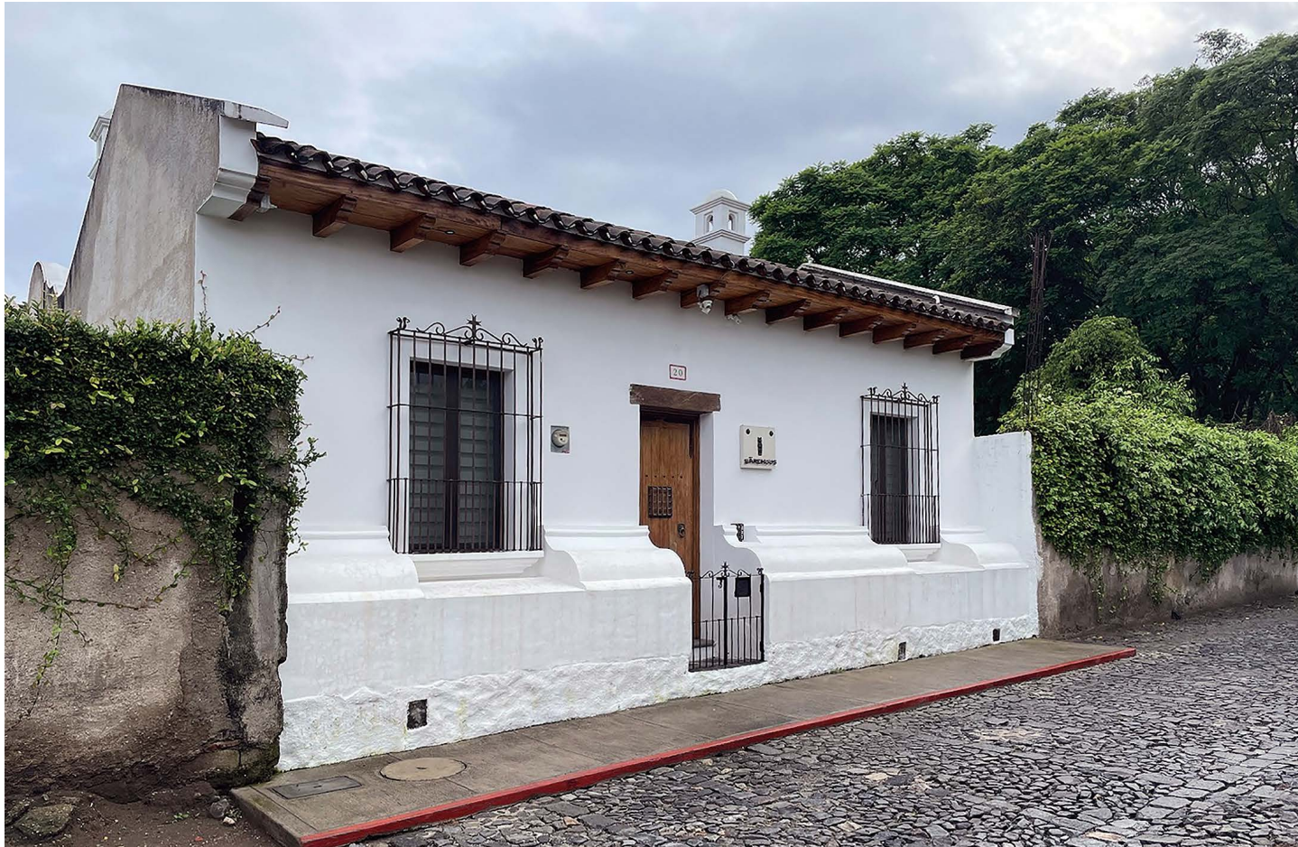
15- Casa Central Oriente del Lateral Sur.
