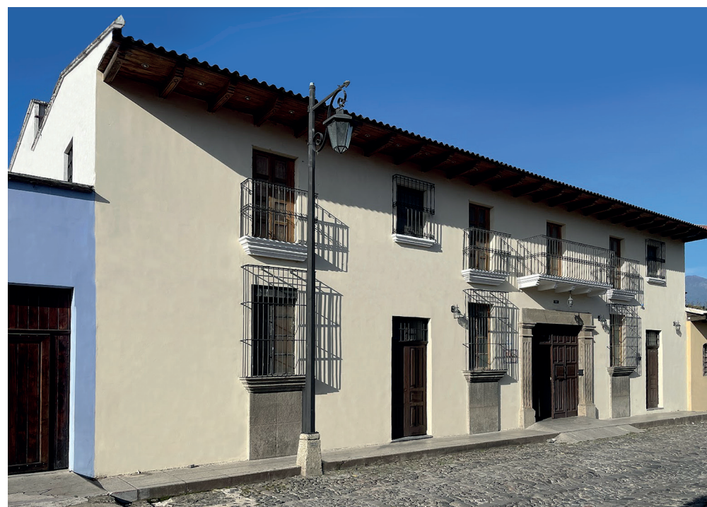
8- Casa Central Oriente del Lateral Norte.
