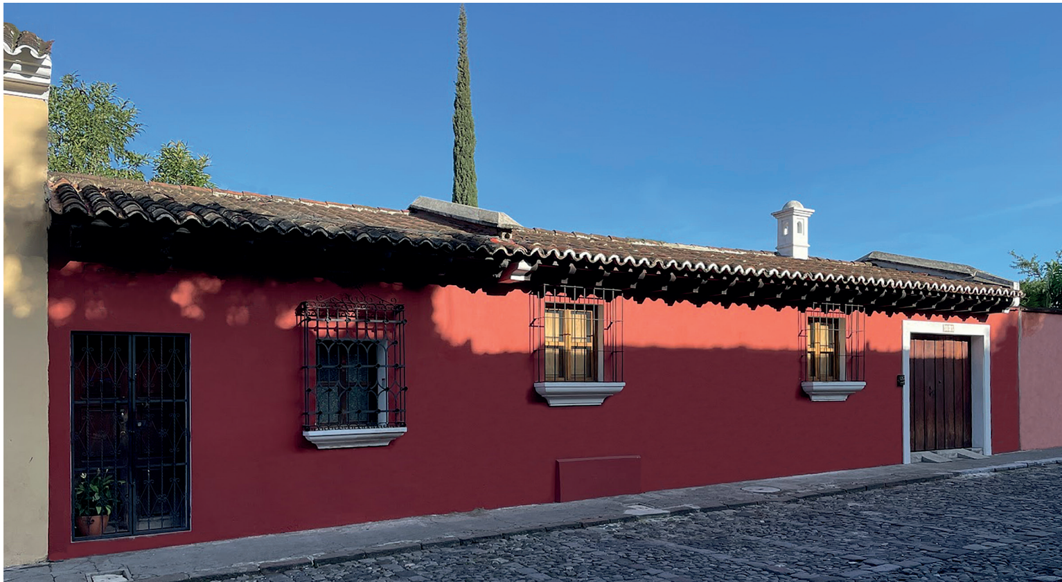
12-Casa Central del Lateral Oriente.
