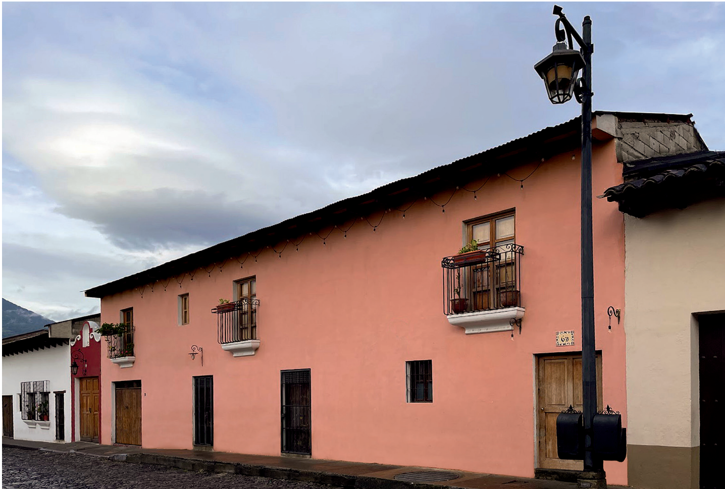
15-Casa Central del Lateral Oriente.
