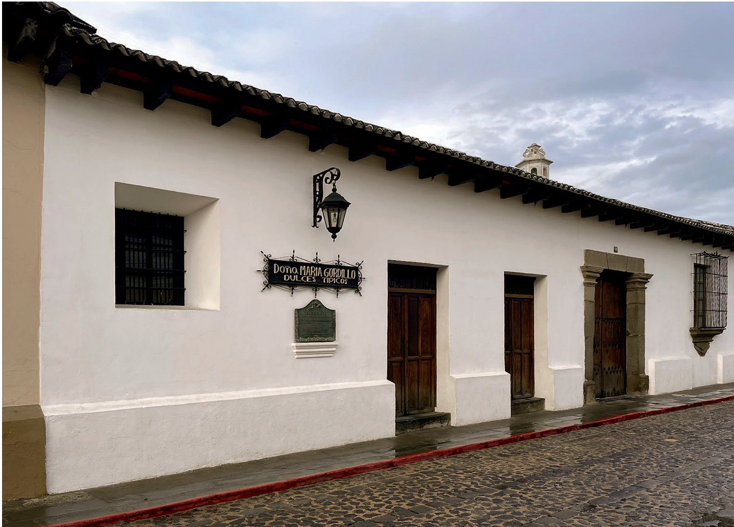
10-Casa Central Oriente del Lateral Norte.
