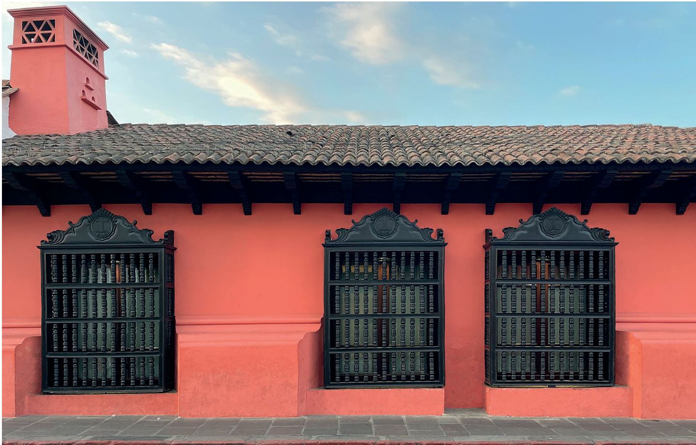
4- Balcones de Casa Esquinera Norponiente.
