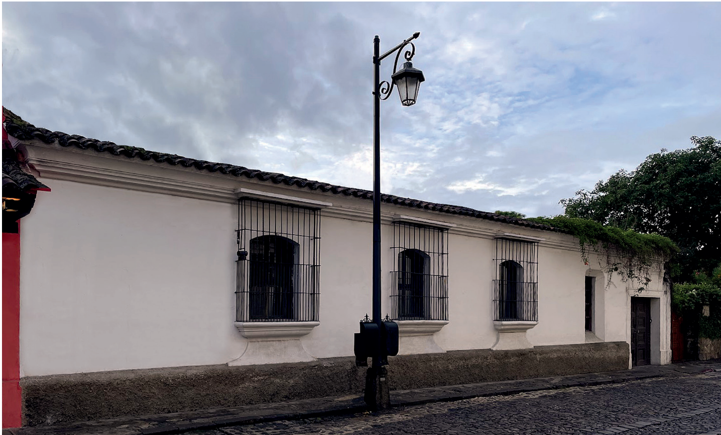
23- Casa Central del Lateral Poniente.
