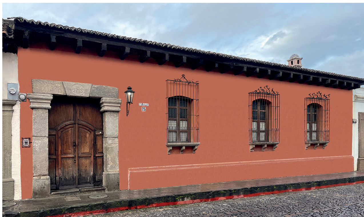
9- Casa Central Oriente del Lateral Norte.
