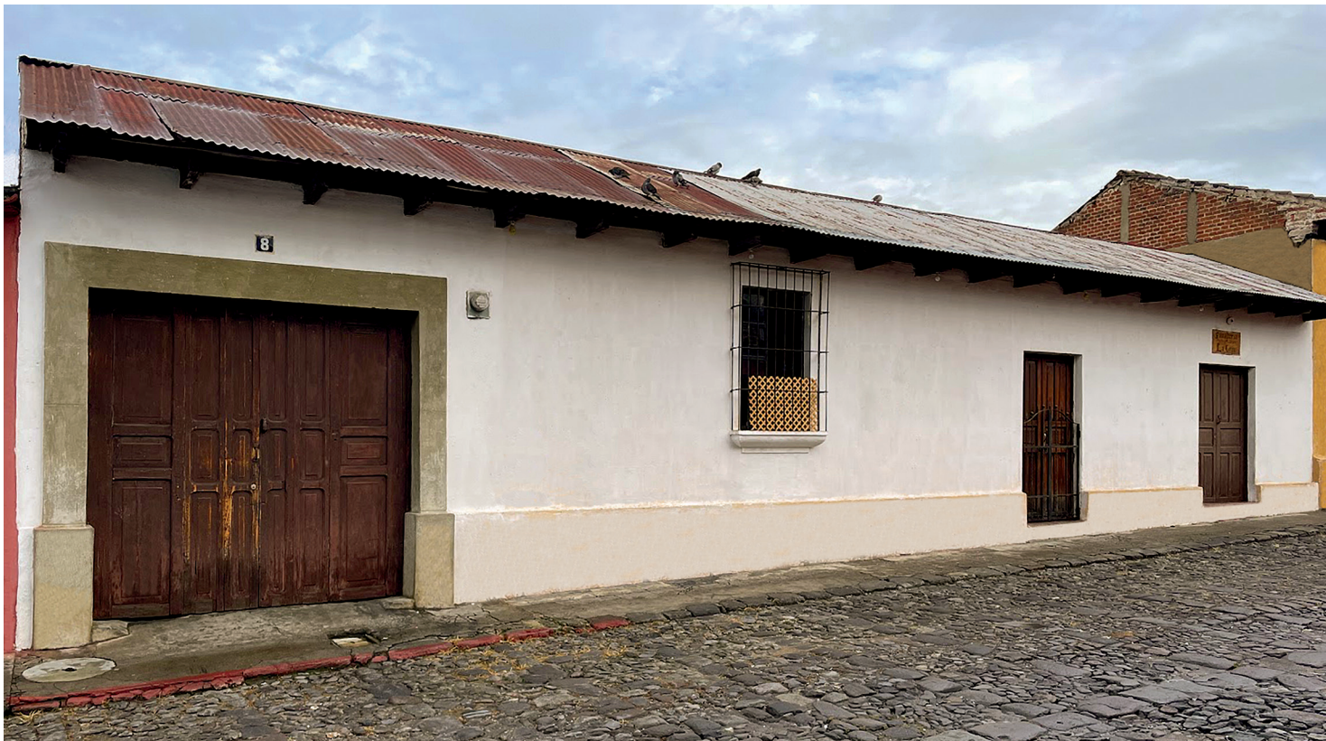
13-Casa Central del Lateral Oriente.
