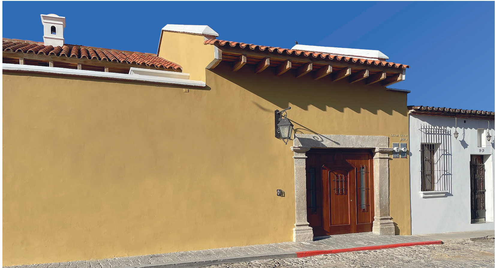
7- Casa Central Oriente del Lateral Norte.
