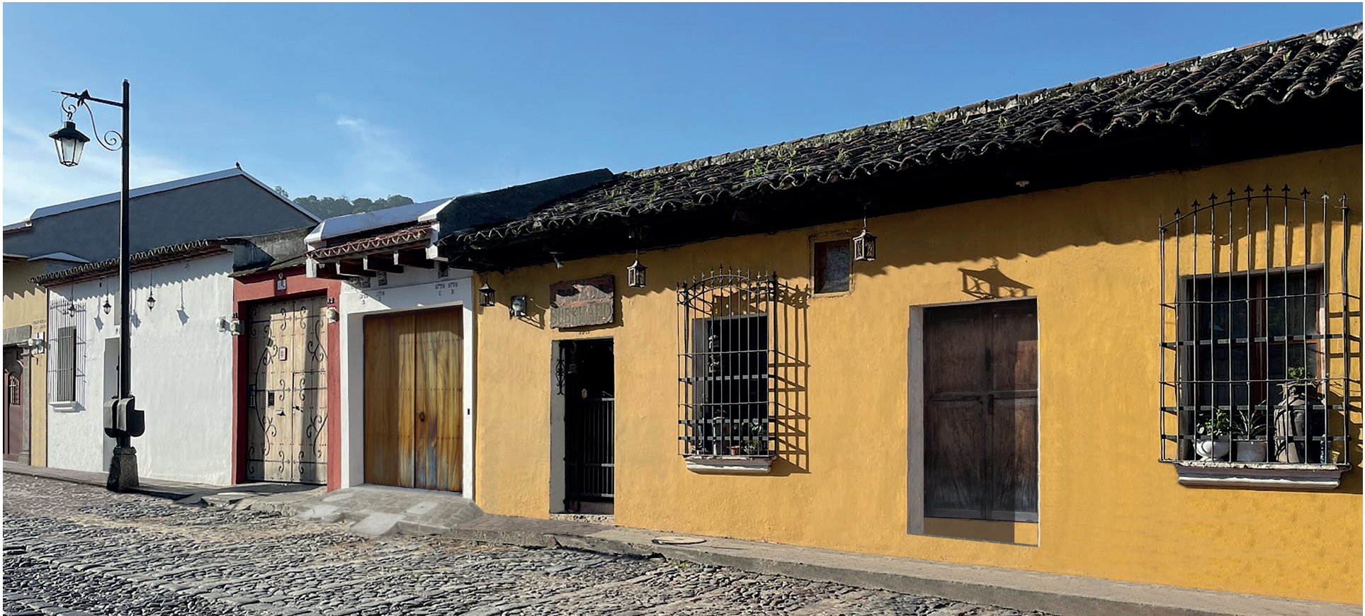
5- Casa Central Poniente del Lateral Norte.
