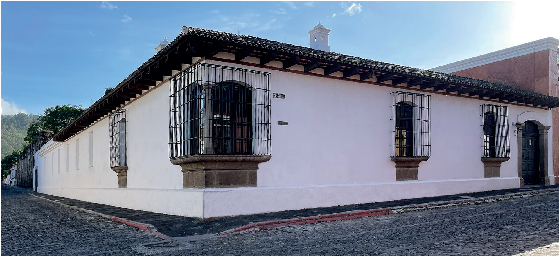
15- Casa Esquinera Surponiente.
