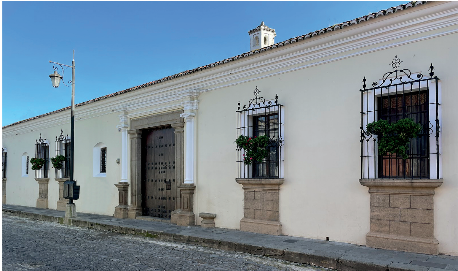
13- Casa Central del Lateral Sur.
